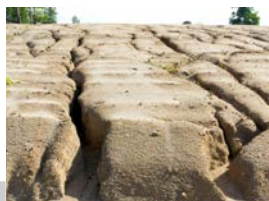
Falta de vegetação
