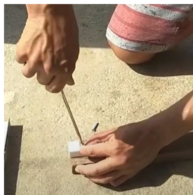
» Figura 3. Fixação da peça de encaixe no caibro.
