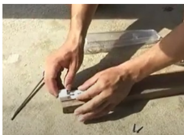
» Figura 2. Posicionamento da peça de encaixe no caibro.
