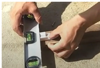
» Figura 2. Posicionamento da peça de encaixe no caibro.
