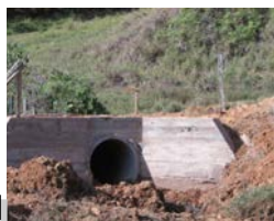
Despejo de alguma tubulação.
