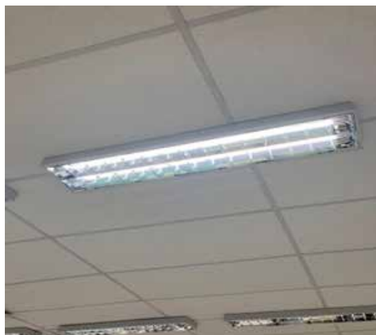
» Figura 2. Iluminação da sala com lâmpadas de LED tubulares
