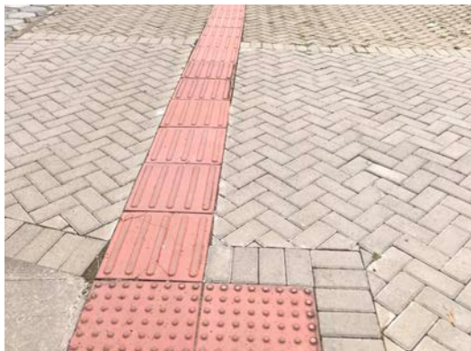
» Figura 20. Calçada tátil.
